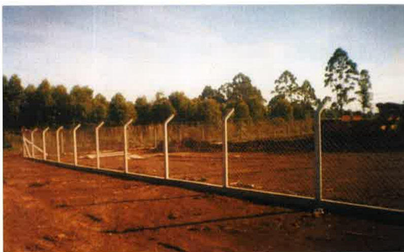
Figura 13. Estacas de concreto a cada 5 metros
