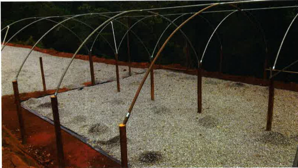
Figura 6. Estrutura metálica em arco em área de sombreamento
