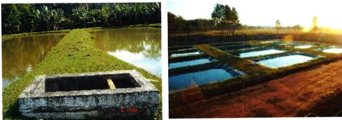
Figura 5 e 6 – Monge entre viveiros escavados
